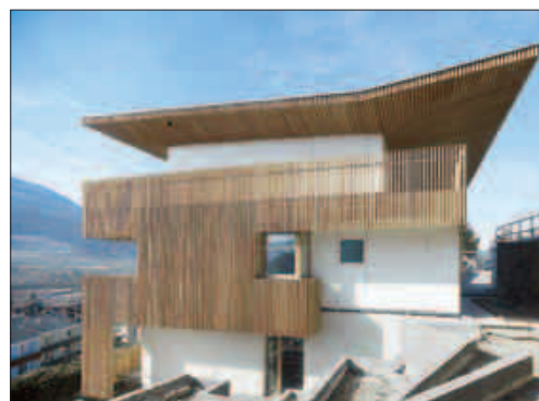
L'edificio residenziale appena ristrutturato a Pergine rispettando il paesaggio
